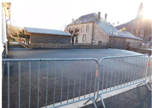
Aménagement et réfection du parking de l'école et de la cour de la cantine
