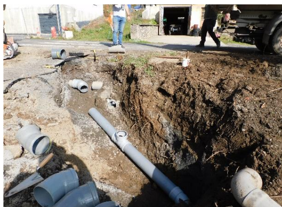
Réparation du réseau eaux usées secteur Insalut
