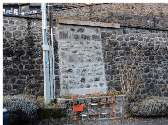
Sécurité : construction d'un mur rue du Puy Griou à Fraise-Haut
