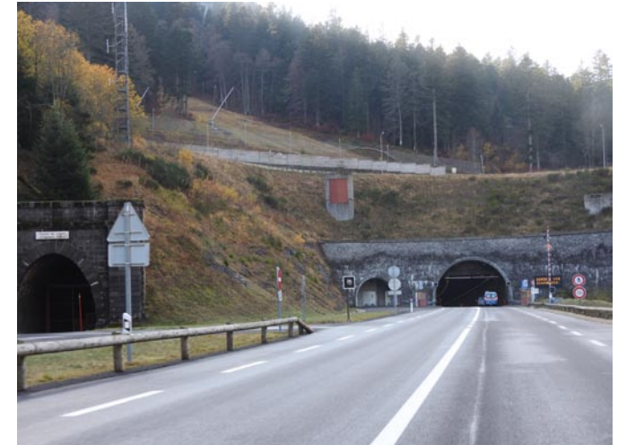
RN 122 - Tunnel du Lioran
