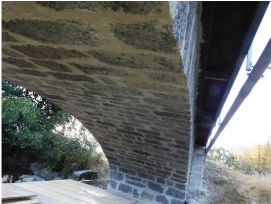
Rénovation du pont de la Mine
