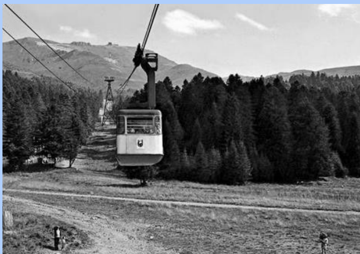
1er essais du téléphérique du Plomb du Cantal
