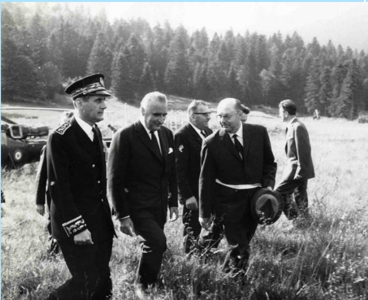
Construction de la gare du téléphérique été 1966
