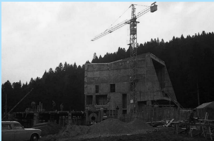
Hector Peshaud et Georges Pompidou visitant le chantier
