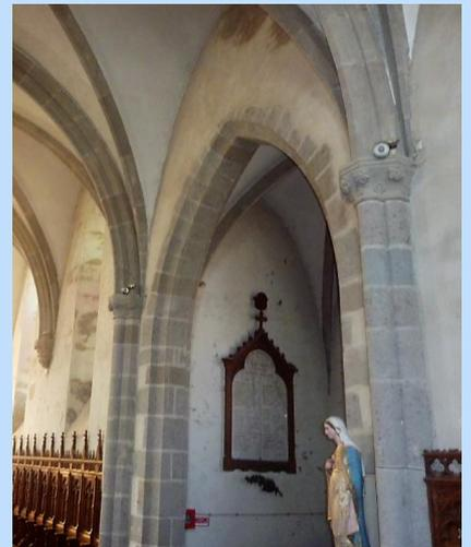
**L'arc formeret (4)** est un arc brisé situé à l'intersection entre le mur porteur (et une voûte en berceau ou d'un quartier de voûte. Il ferme une travée de
