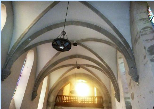
**L'arc brisé (1)** est destiné à franchir un espace, plus ou moins grand, par la rencontre de deux éléments courbes, reposant sur deux points d'appui, les **piédroits (9)**, et destiné à couvrir une ouverture.
